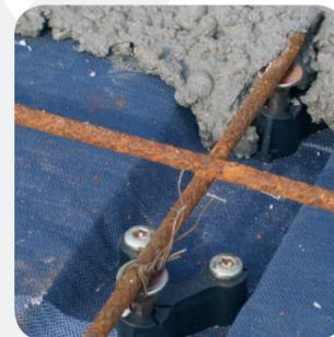
senza del connettore. EFG Power System "V" è stato progettato anche per essere un valido appoggio per la rete elettrosaldata. In realtà esistono in commercio degli elementi distanziali specifici, e dal costo limitato, ma perché non realizzare due operazioni in una sola: montare un sistema di collaborazione che sia anche un distanziale per mantenere il giusto "copri filo"?
