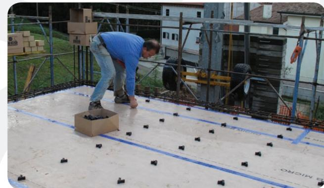
Rispetto ai tradizionali sistemi di connessione il risparmio del tempo di montaggio è assolutamente elevato. Oltre alla numerosità decisamente inferiore non è necessaria alcuna operazione di foratura dei travi (tranne con il PSV 6), le viti sono di diametro 8,0 mm autoforanti e possono essere inserite anche in legni duri con semplici avvitatori, anche a batteria.
